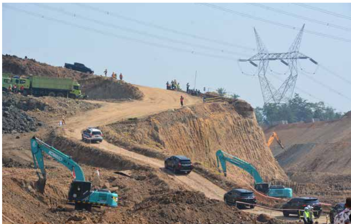
Kontruksi pembangunan Jalan Tol Cijago Seksi 3
