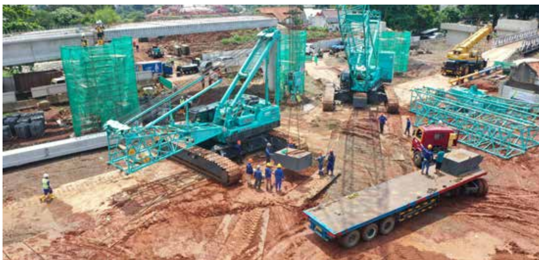
Konstruksi Pembangunan Jalan Tol Cijago Seksi 3
