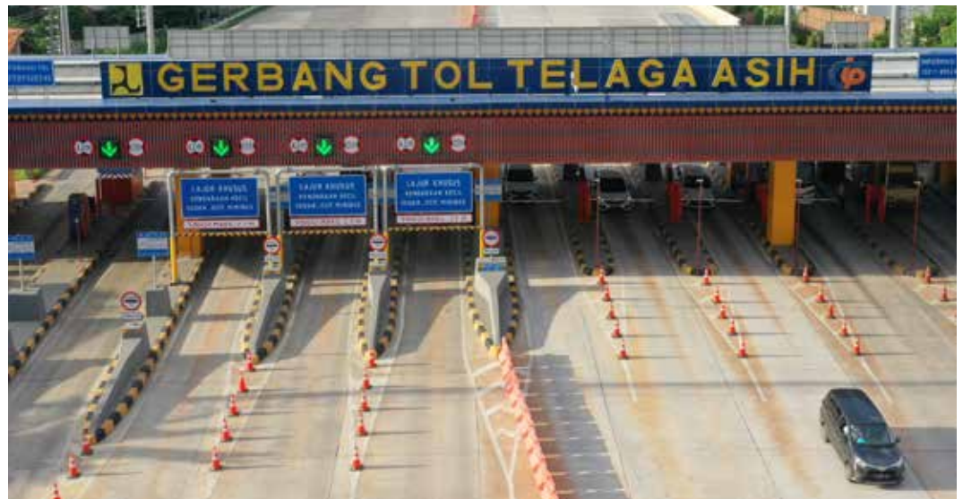
Gerbang Tol Telaga Asih Jalan Tol Cibitung-Cilincing Seksi 1
