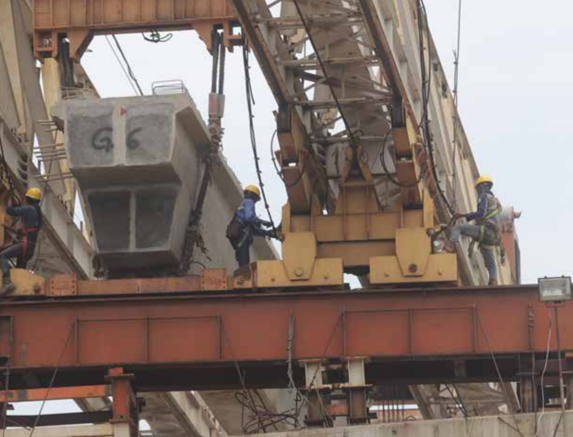
Pekerja konstruksi pembangunan Jalan Tol Cimanggis-Cibitung Seksi 2
