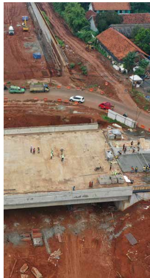
Pekerja konstruksi pembangunan Jalan Tol Serpong-Balaraja
