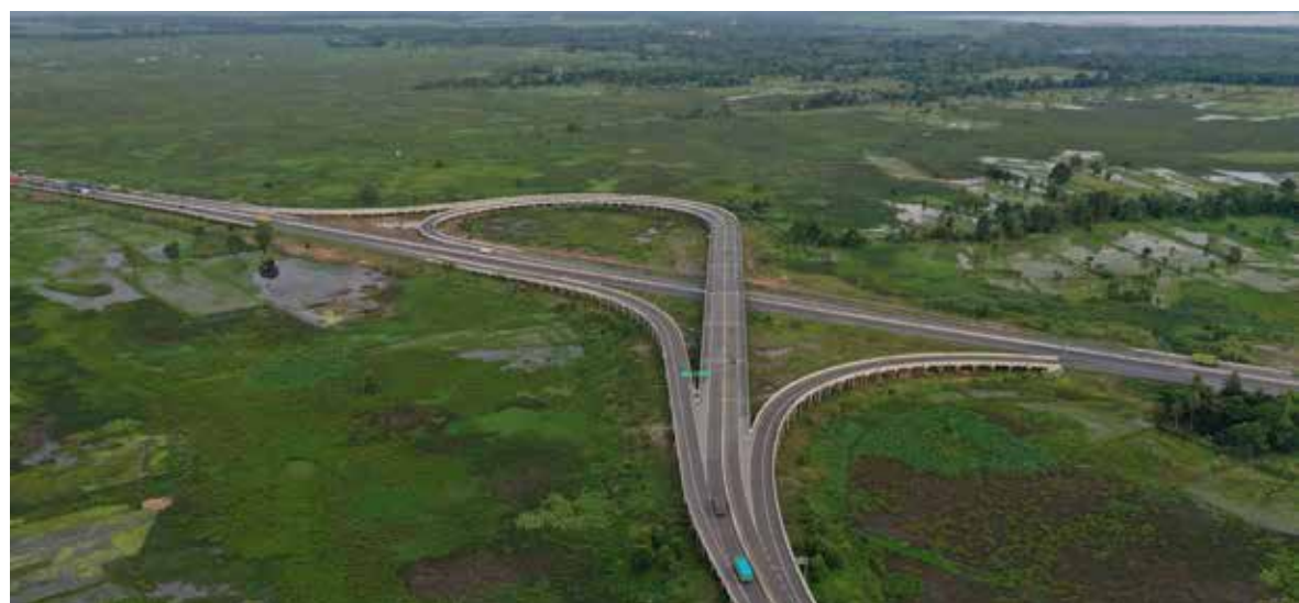
Jalan Tol Kayu Agung-Palembang (Keramasan)
