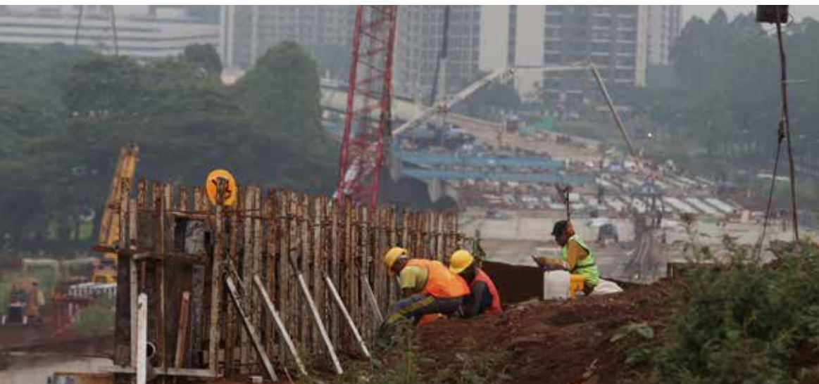
Pekerja konstruksi pembangunan Jalan Tol Serpong-Balaraja
