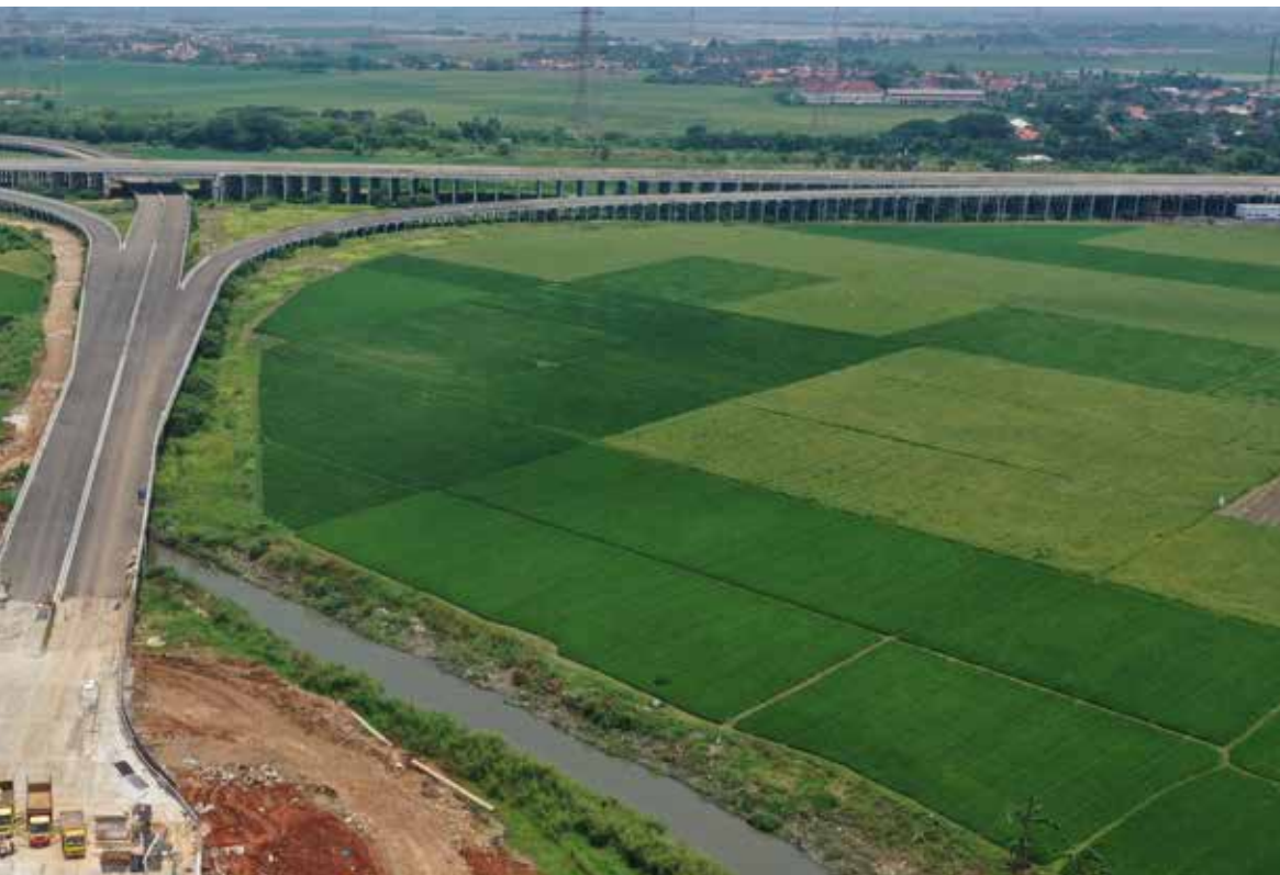
Pekerja kontruksi pembangunan Jalan Tol Cibitung-Cilincing Seksi 2
