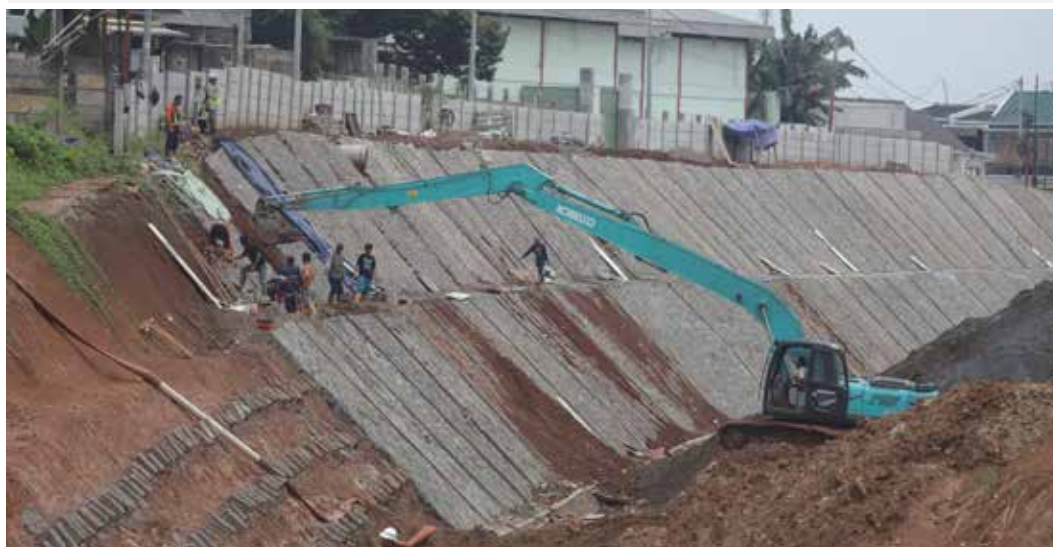
Pekerja konstruksi pembangunan Jalan Tol Serpong-Balaraja
