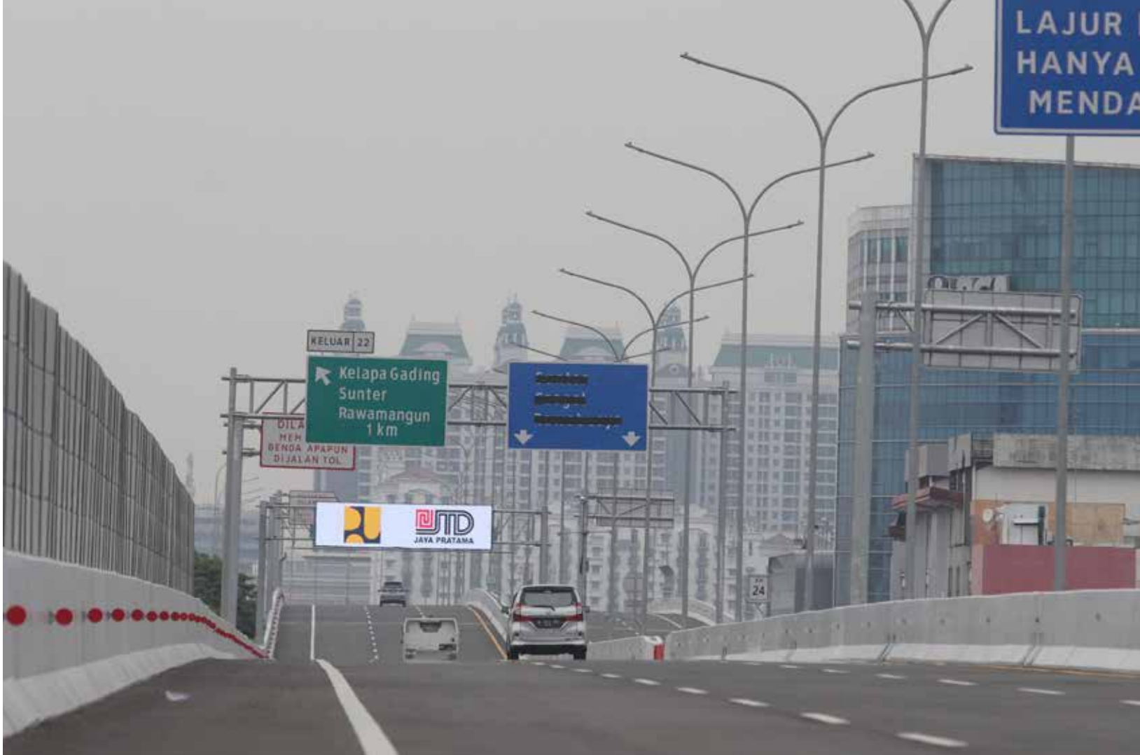
Informasi jalan & perbaikan yang selalu diperbaharui oleh BUJT untuk pengguna di Jalan Tol Kelapa Gading-Pulo Gebang
