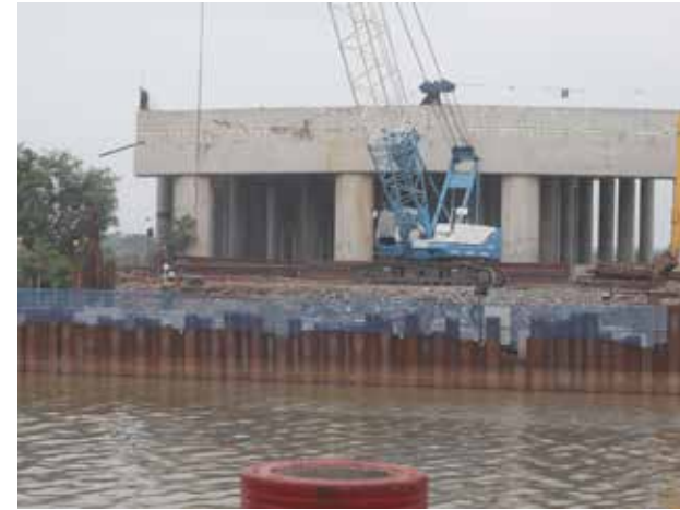
Pembangunan Jalan Tol Cibitung-Cilincing
