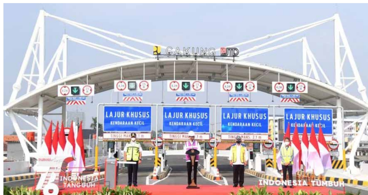
Jalan Tol 6 Ruas, Jalan Tol Dalam Kota Segmen Kelapa Gading-Pulogebang
