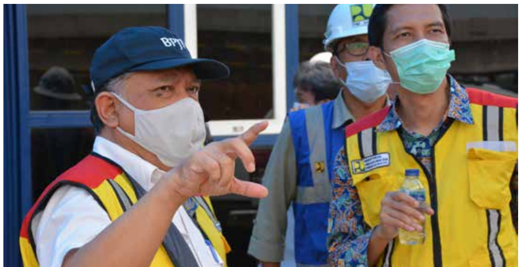
Kunjungan Lapangan Anggota BPJT Unsur Profesi, Koentjahjo Pamboedi ke Pembangunan Jalan Tol Cisumdawu Seksi 6
