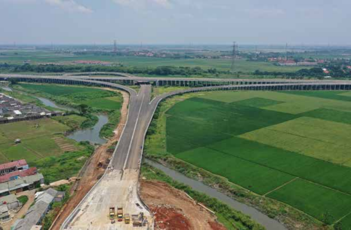
Pekerja konstruksi pembangunan Jalan Tol Cibitung-Cilincing Seksi 2
