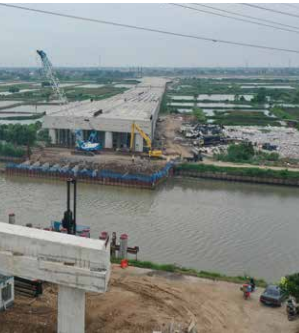
Pekerja konstruksi pembangunan Jalan Tol Cibitung-Cilincing Seksi 4
