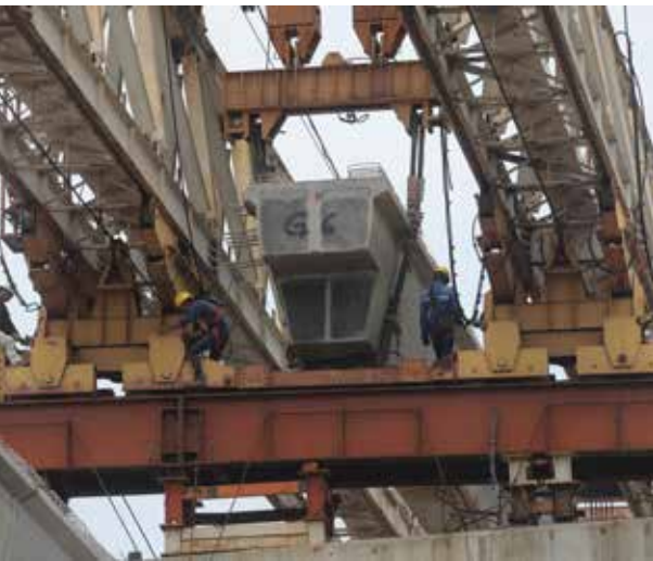
Pekerja konstruksi pembangunan Jalan Tol Cimanggis-Cibitung Seksi 2
