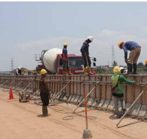
Pekerja konstruksi pembangunan Jalan Tol Cilincing Seksi 2
