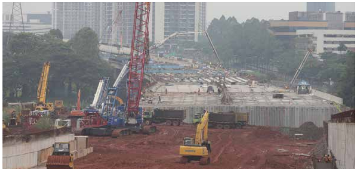
Pekerja konstruksi pembangunan Jalan Tol Serpong-Balaraja
