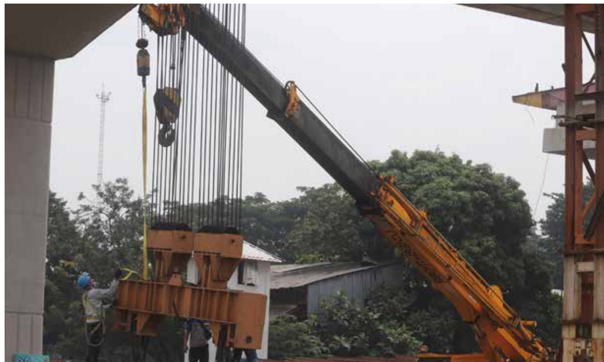
Pekerja konstruksi pembangunan Jalan Tol Cimanggis-Cibitung Seksi 2
