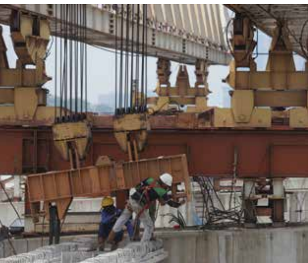
Pekerja konstruksi pembangunan Jalan Tol Cimanggis-Cibitung Seksi 2
