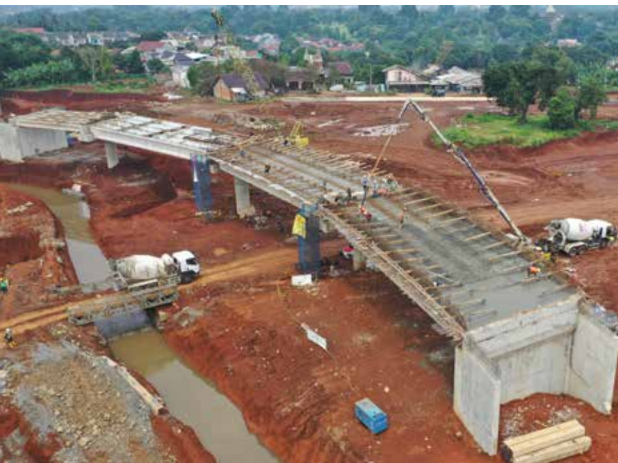
Pekerja konstruksi pembangunan Jalan Tol Cijago Seksi 3
