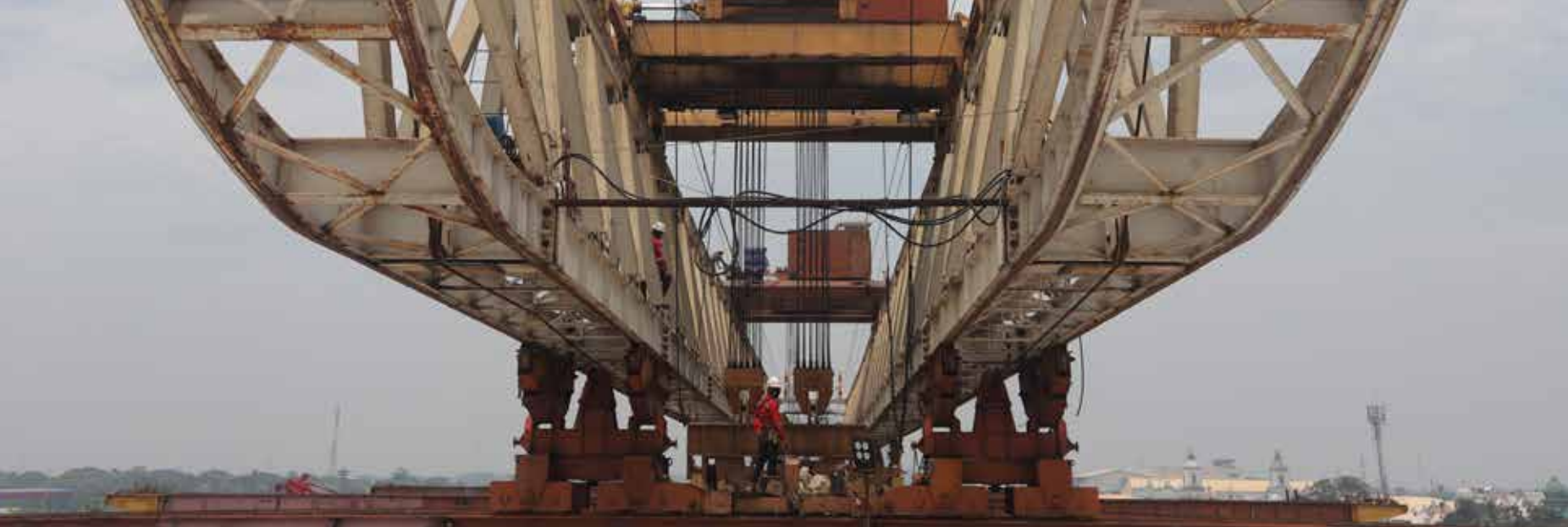
Pekerja konstruksi pembangunan Jalan Tol Cimanggis-Cibitung Seksi 2
