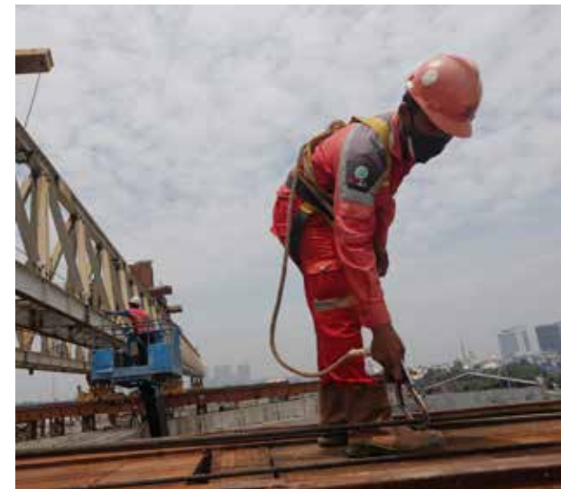
Pekerja konstruksi pembangunan jalan tol.
