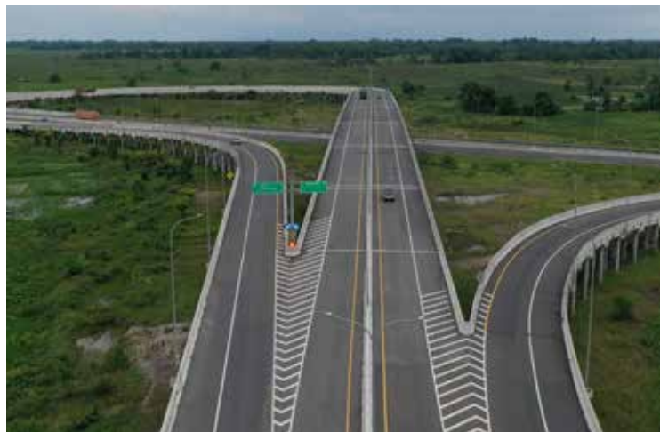
Jalan Tol Trans Sumatera, Kayu Agung-Keramasan
