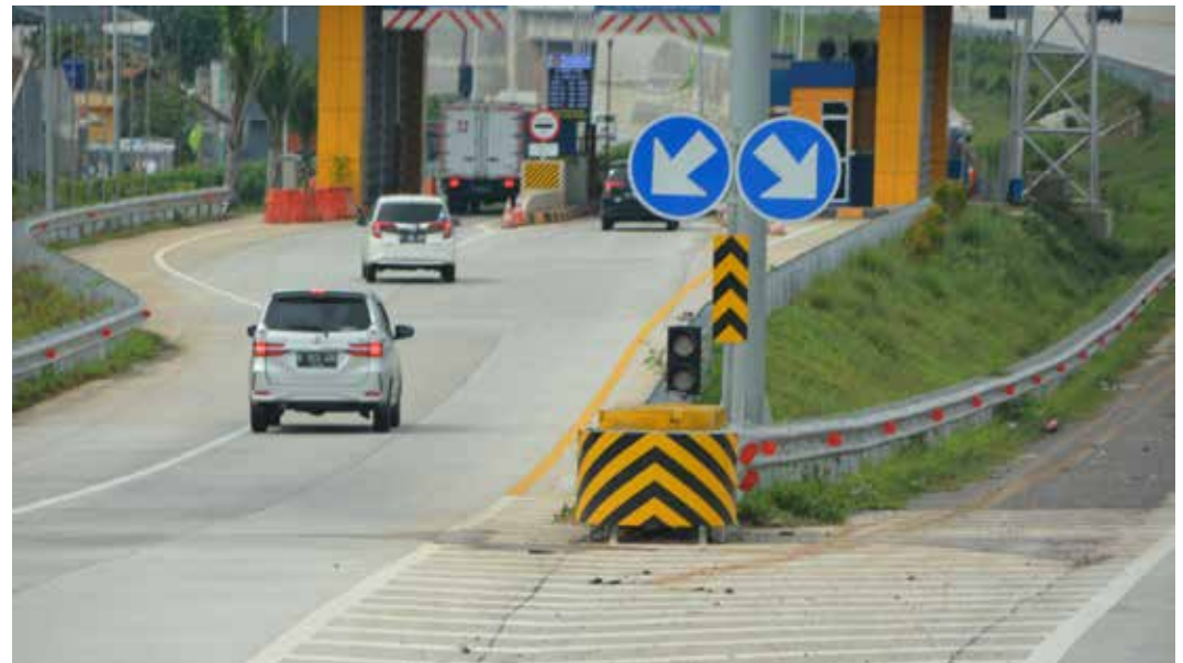
Crash cushion di gerbang tol keluar Buaran Indah Jalan Tol Serpong-Cinere
