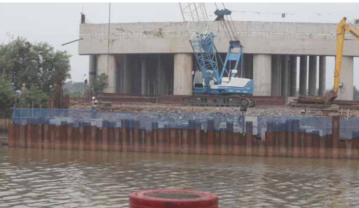
Pembangunan Jalan Tol Cibitung-Cilincing
