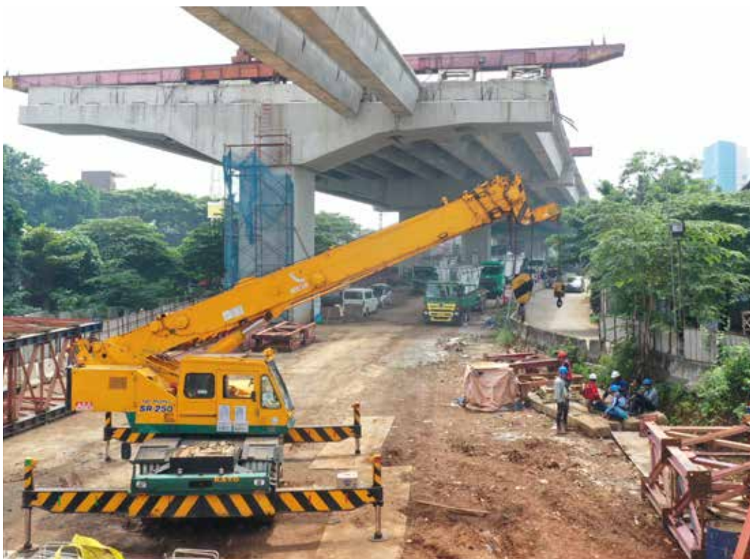
Pekerja konstruksi pembangunan Jalan Tol Cijago Seksi 3A-Jembatan Tanah Baru
