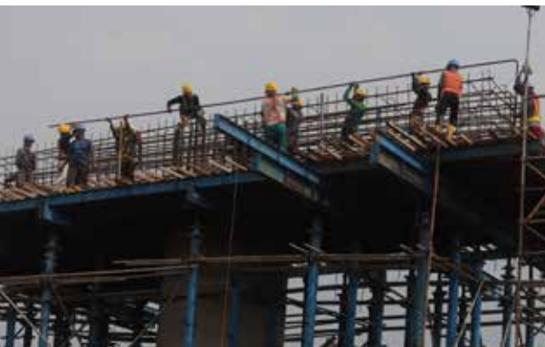
Pekerja konstruksi Jalan Tol Cijago Seksi 3
