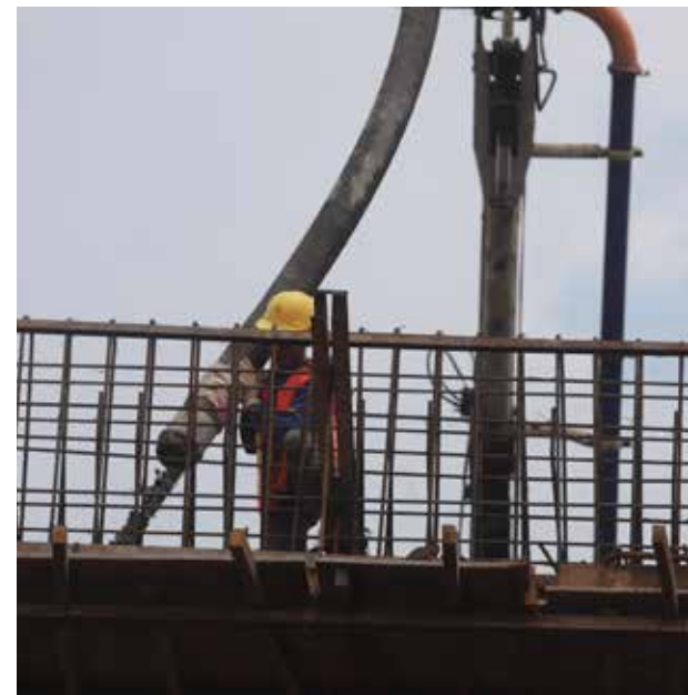
Pekerja konstruksi pembangunan Jalan Tol Cijago Seksi 3
