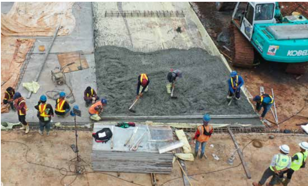
Pekerjaan konstruksi di Jalan Tol Serpong-Balaraja
