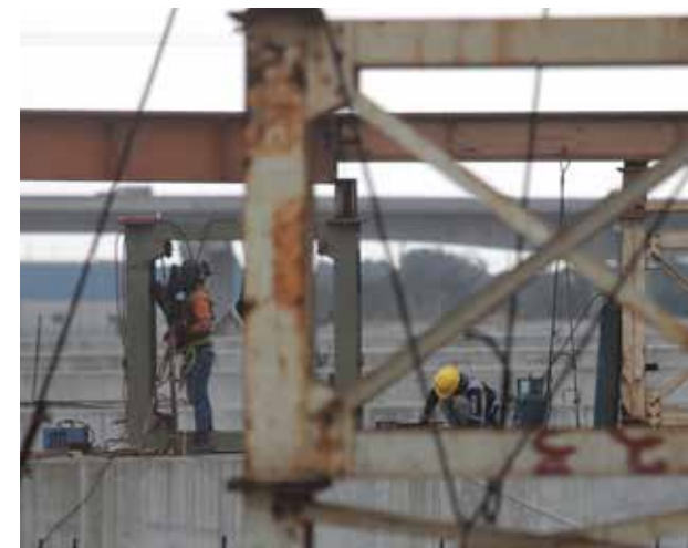
Pekerja konstruksi pembangunan Jalan Tol Cimanggis-Cibitung Seksi 2
