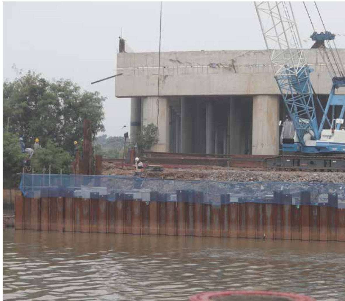
Pembangunan Jalan Tol Cibitung-Cilincing
