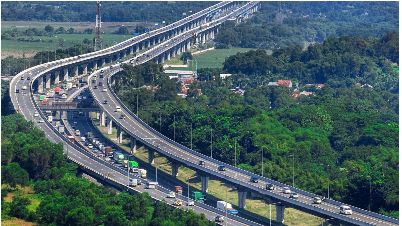
Kepadatan kendaraan di jalan tol MBZ
