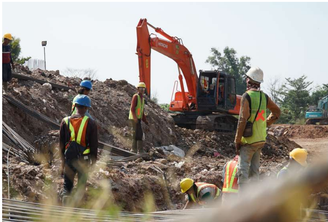
Pekerja Sedang Melakukan Galian Akses Jalan Tol Baru Dengan Alat Berat pada Pembangunan Jalan Tol Cinere – Jagorawi
