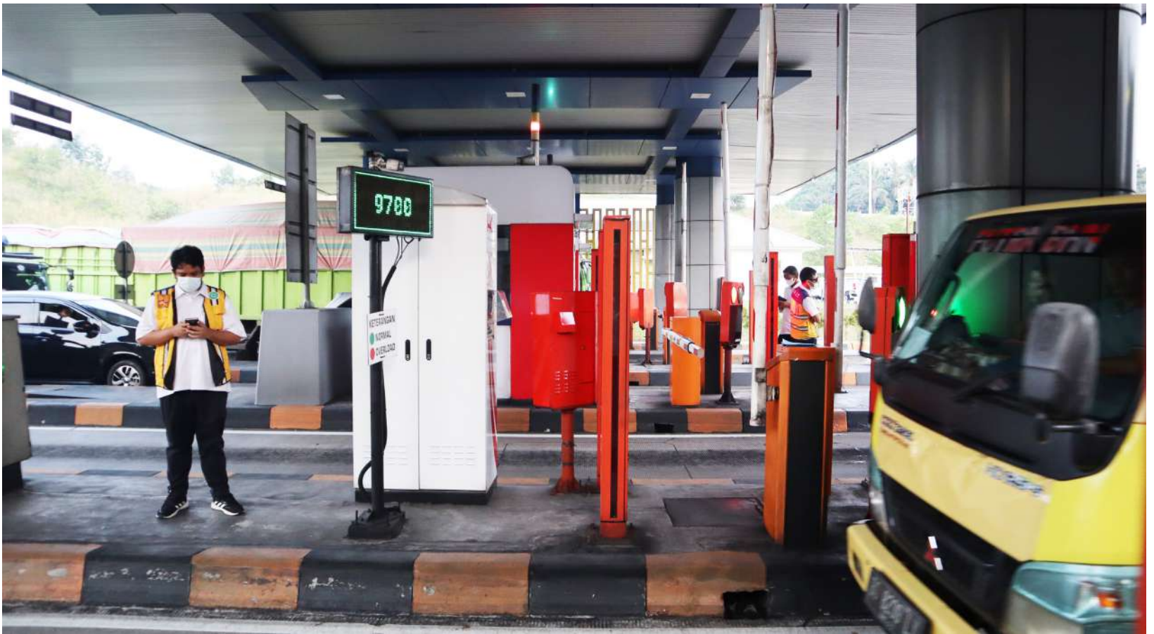
Pengendalian Kendaraan Over Dimensi Over Load menggunakan WIM
