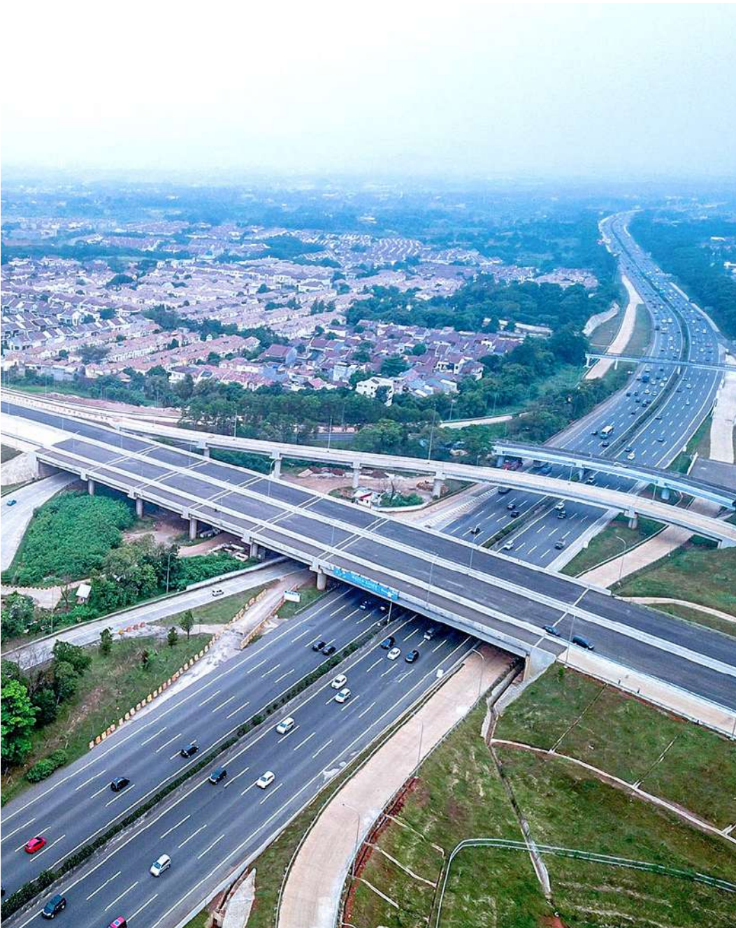
Jalan Tol Cimanggis - Cibitung
