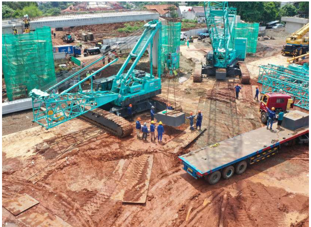
Pekerja pembangunan jalan tol Cinere - Jagorawi
