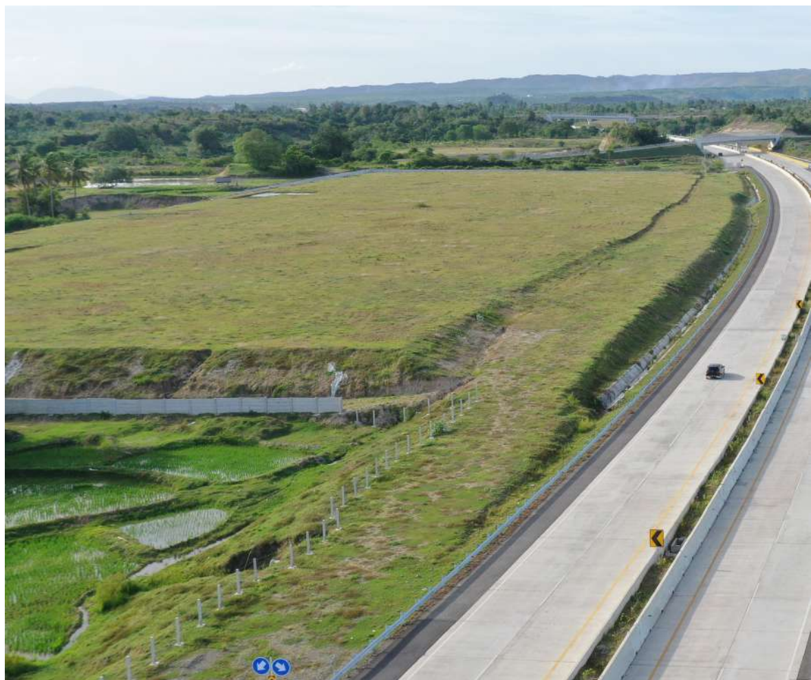
Jalan Tol Sigli - Banda Aceh
