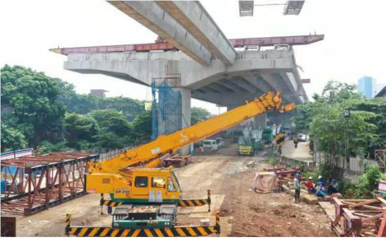
Pemasangan Girder Konstruksi Tol Cimanggis – Cibitung, Jalan Tol Cengkareng – Kunciran
