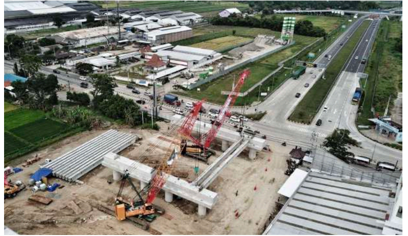
Konstruksi Tol Solo – Yogyakarta – NYIA Kulon Progo
