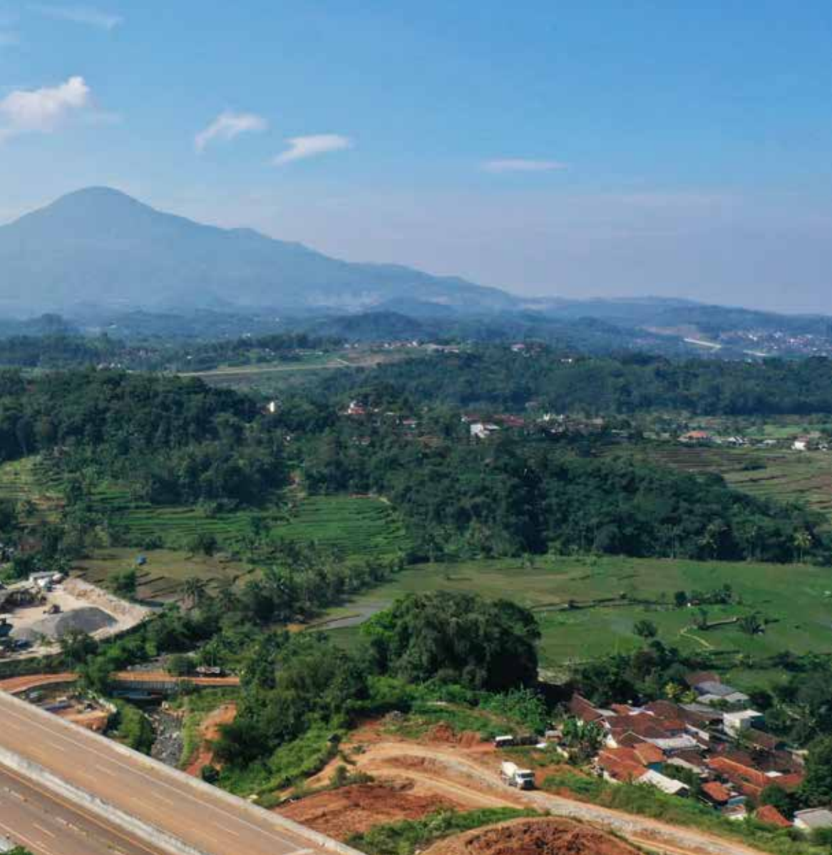
Jalan Tol Cileunyi-Sumedang-Dawuan (Cisumdawu), Jawa Barat
