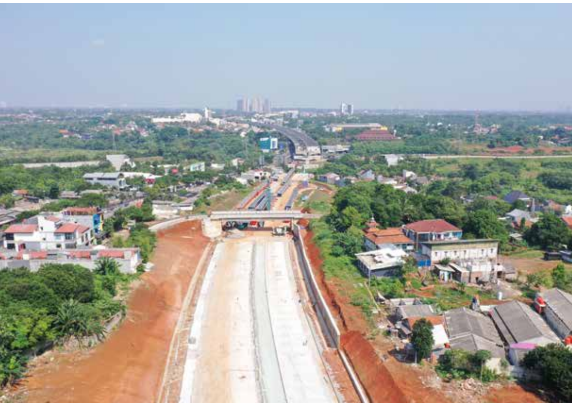
Pembangunan Jalan Tol Cimanggis-Cibitung Seksi 2A
