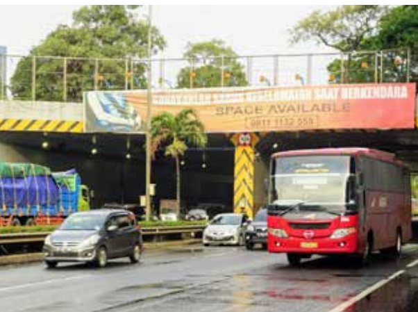
Jalan Tol JORR-S
