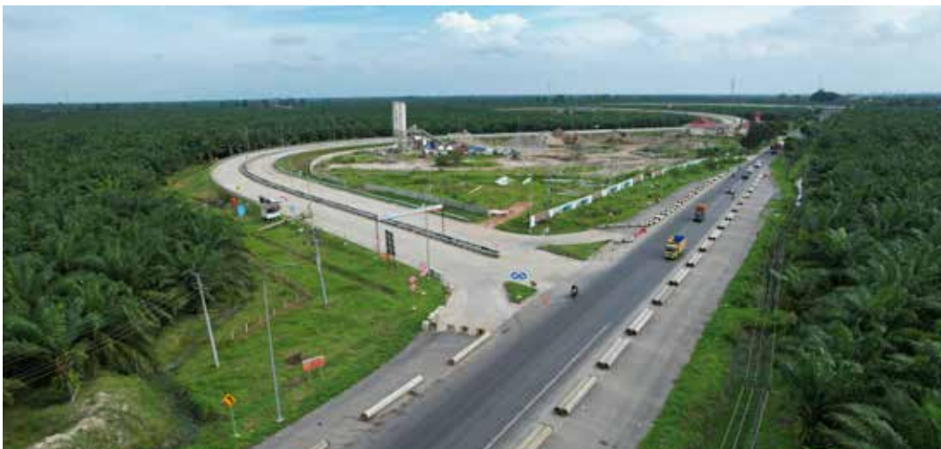
Pembangunan Tol Kuala Tanjung-Parapat Seksi 1 dan 2.
