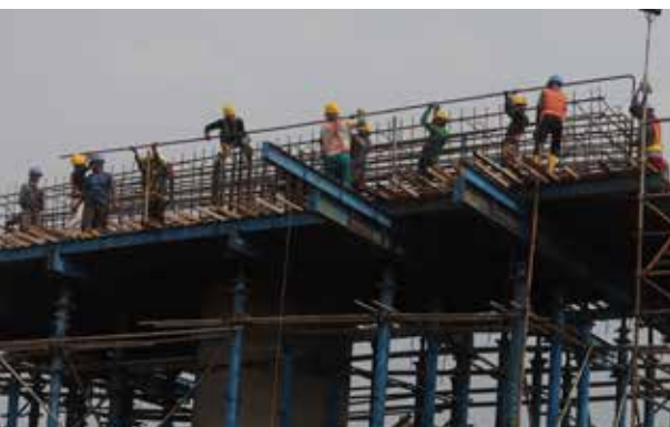
Pekerja konstruksi Jalan Tol Cijago Seksi 3
