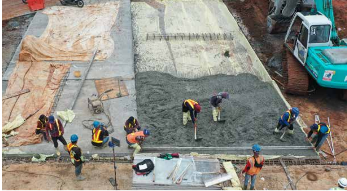
Pekerja konstruksi pembangunan jalan tol.
