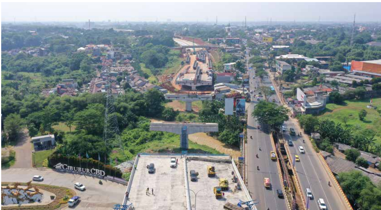
Pembangunan Jalan Tol Cimanggis-Cibitung Seksi 2A
