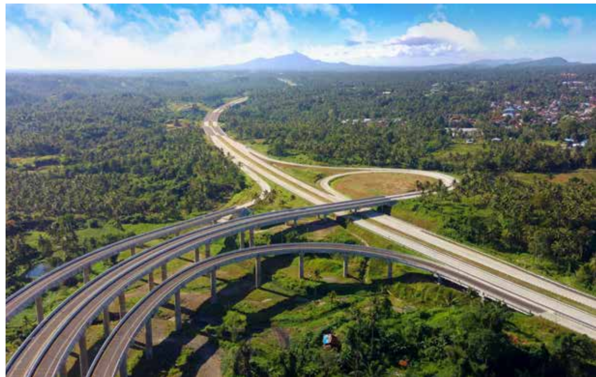
Simpang Susun Airmadidi, Jalan Tol Manado-Bitung
