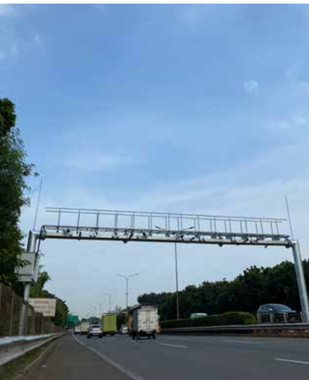
Pemasangan gantry sistem transaksi multi lane free flow (MLFF) di Jalan Tol JORR S
