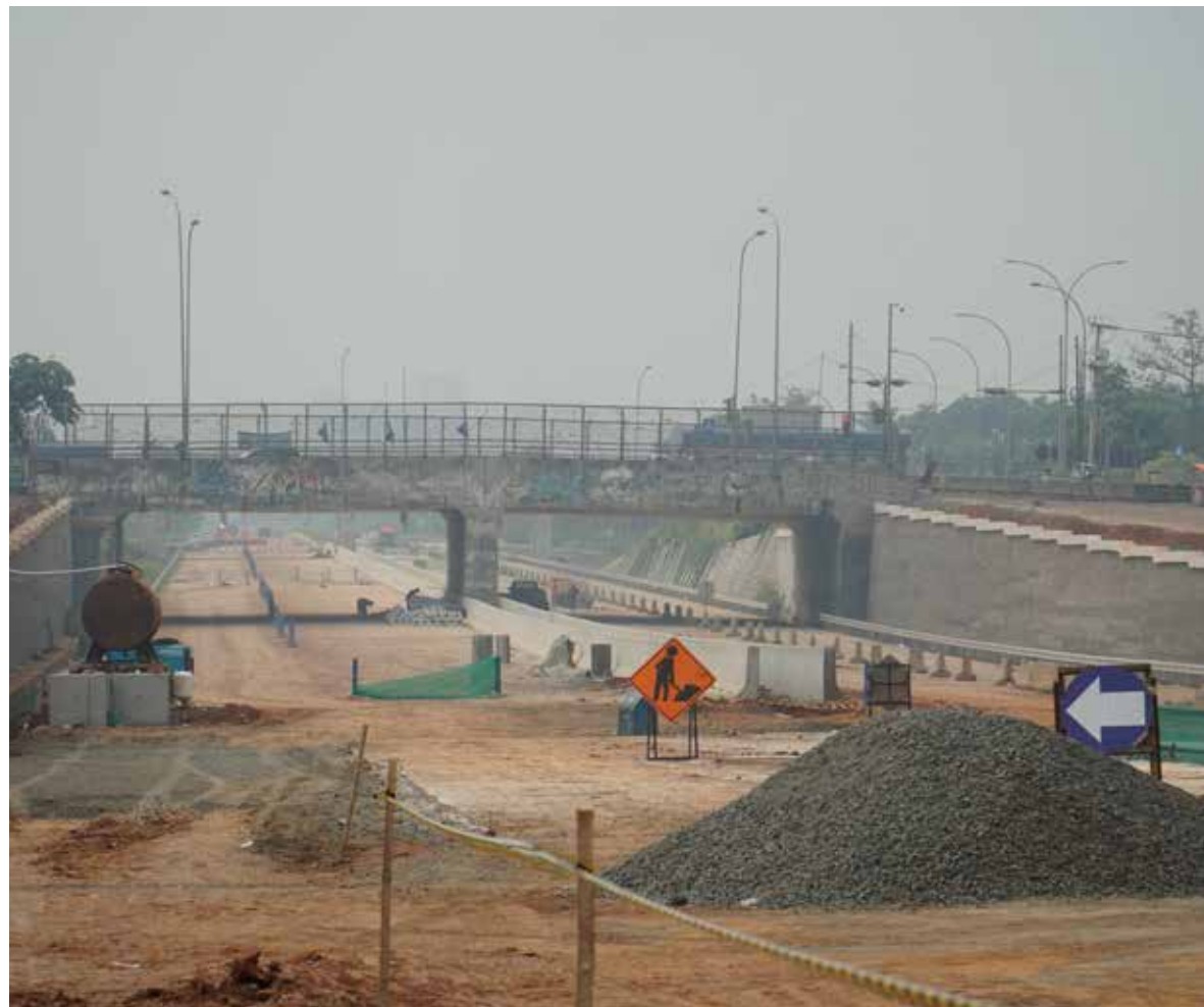
Pembangunan Tol Cijago Seksi 3A dan B.
