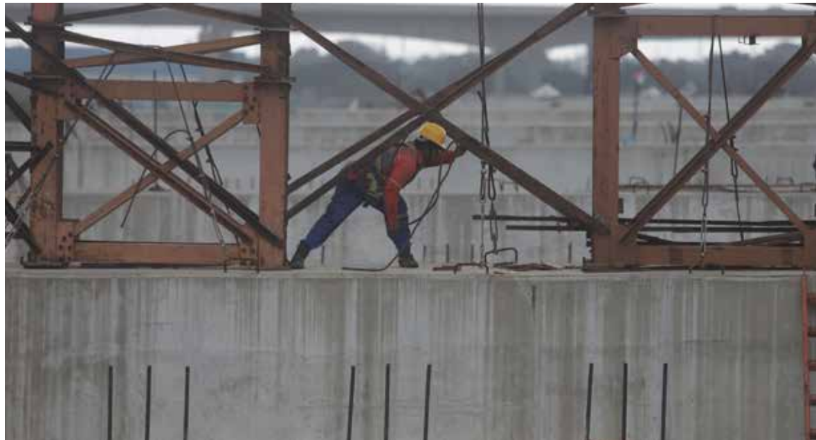
Pekerja konstruksi pembangunan jalan tol.
