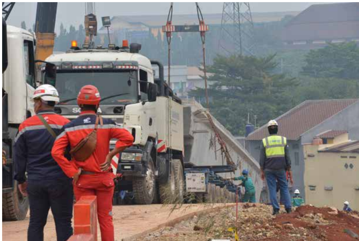
Pekerja di proyek pembangunan jalan tol Cimanggis-Cibitung
