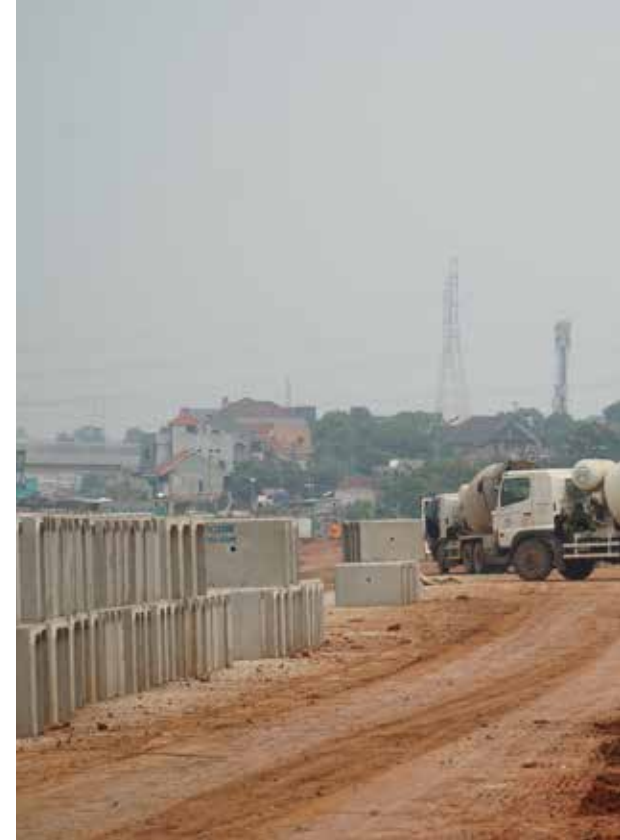
Pembangunan Tol Cijago Seksi 3A dan B.
