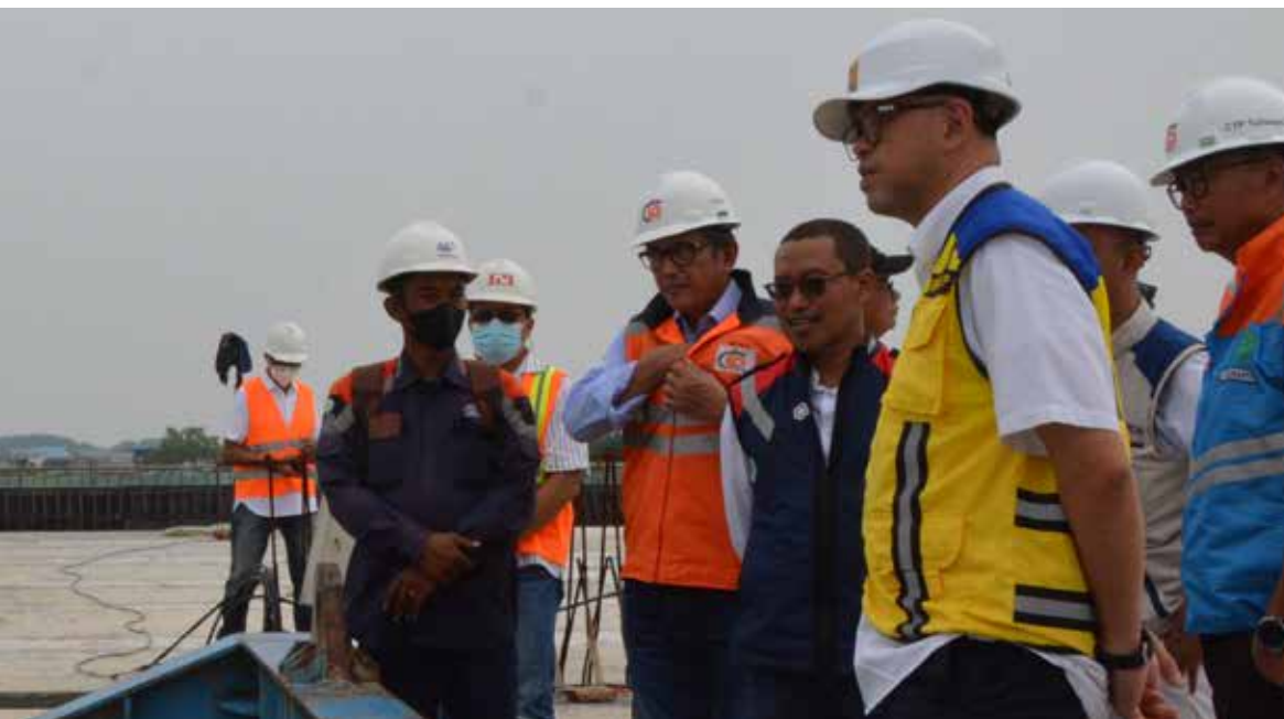
Kunjungan lapangan pembangunan jalan tol Cibitung - Cilincing Seksi 4 oleh Kepala BPJT Danang Parikesit
